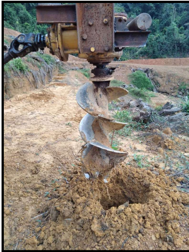
Gambar 16: Menggali lubang menggunakan auger yang dipasang pada traktor
