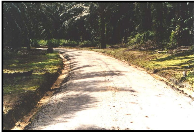
Gambar 7: Keadaan jalan utama ladang yang telah siap 'cambering'
