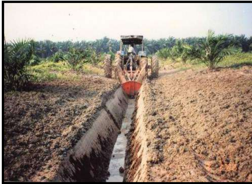
Gambar 8: Kerja-kerja mencuci parit dengan menggunakan 'ditcher'
