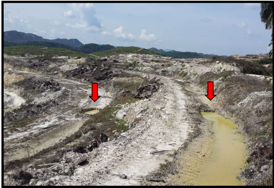
Gambar 12: Fungsi silt pit yang memerangkap air hujan
