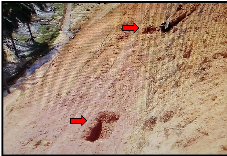
Gambar 13: Kedudukan silt pit pada teres
