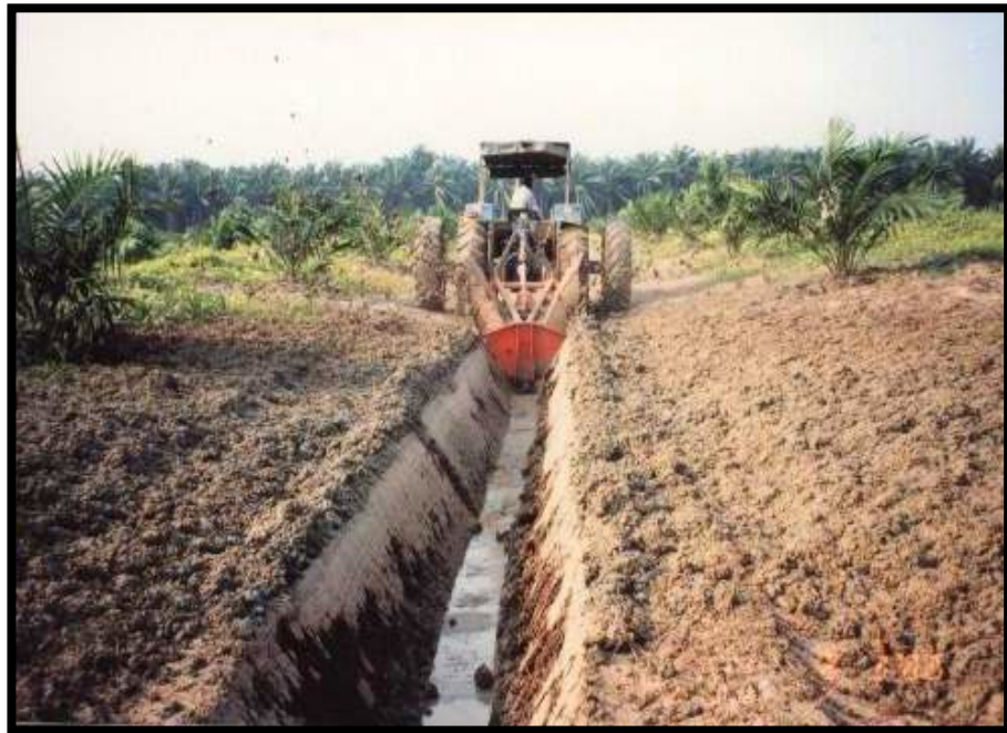
Gambar 8: Kerja-kerja mencuci parit dengan menggunakan 'ditcher'
