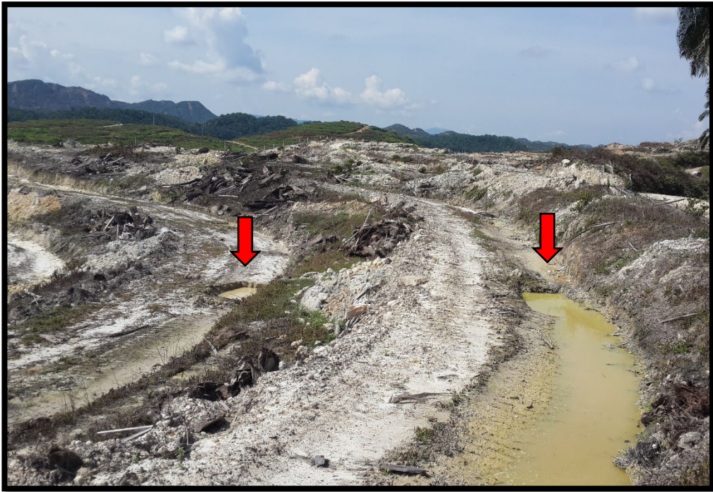
Gambar 12: Fungsi silt pit yang memerangkap air hujan
