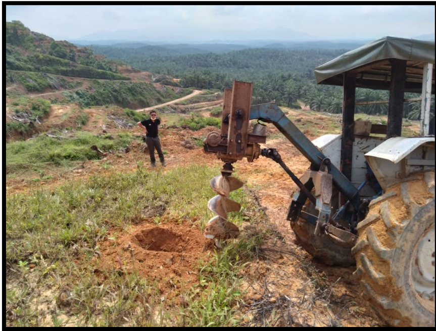
Gambar 15: Menggali lubang menggunakan auger yang dipasang pada traktor
