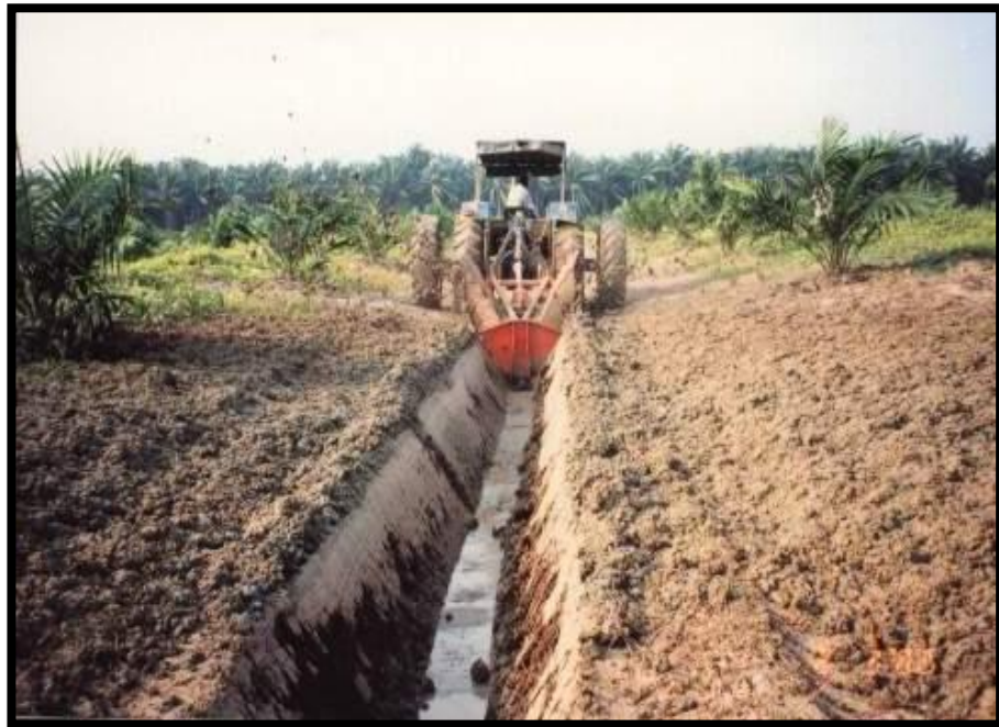
Gambar 8: Kerja-kerja mencuci parit dengan menggunakan 'ditcher'
