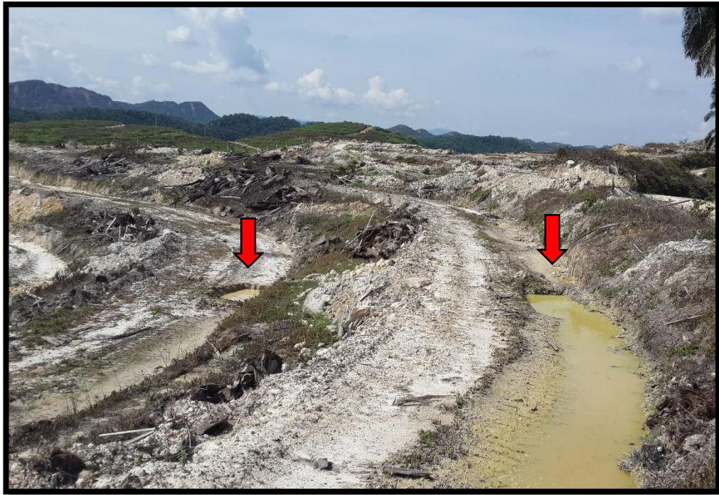
Gambar 12: Fungsi silt pit yang memerangkap air hujan
