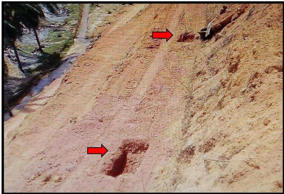
Gambar 13: Kedudukan silt pit pada teres
