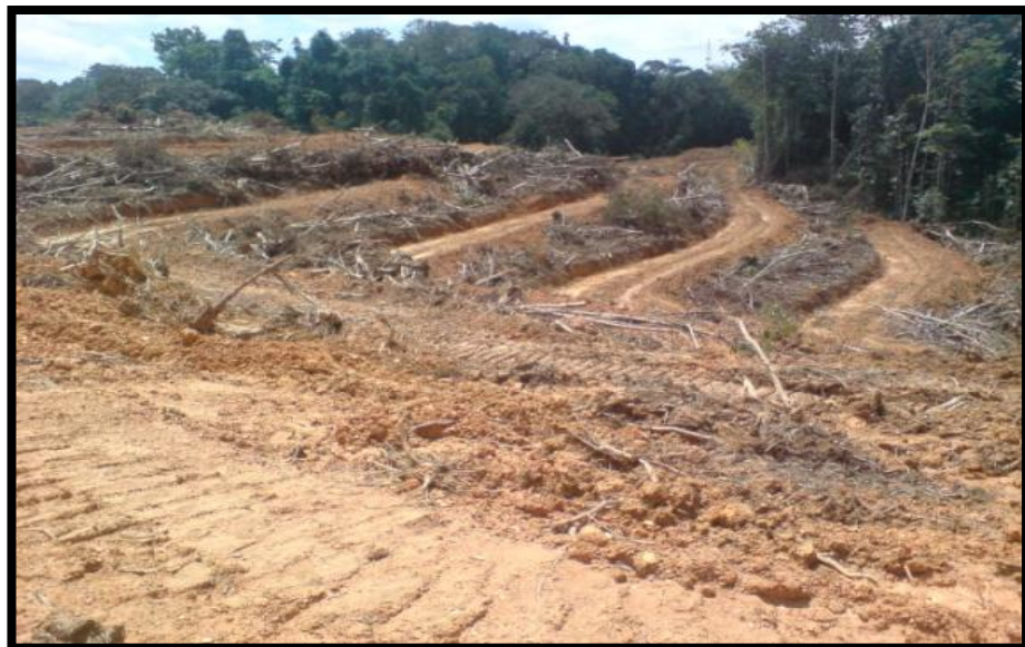
Gambar 5: Keadaan tanah ladang yang siap dibina teres
